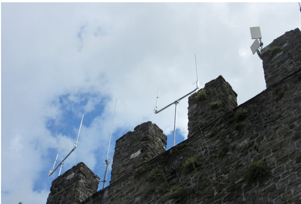
Antenne verticali posizionate sul bastione del Castello di Gorizia
